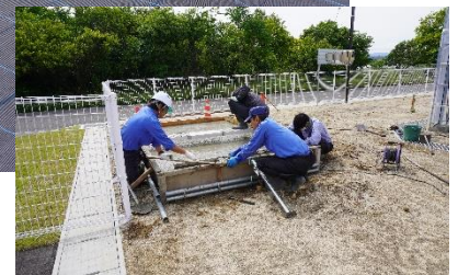
ポンプ設置の土台を作る作業員
