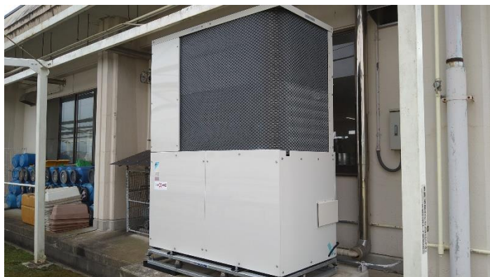
新しく設置になったガスヒートポンプエアコン室外機
