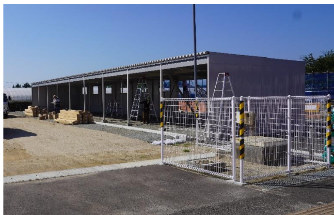
倉庫の建物部材の組み立て作業の様子
